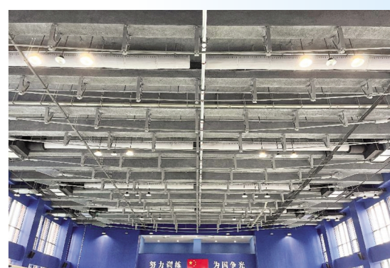
↑弦支混凝土梁
