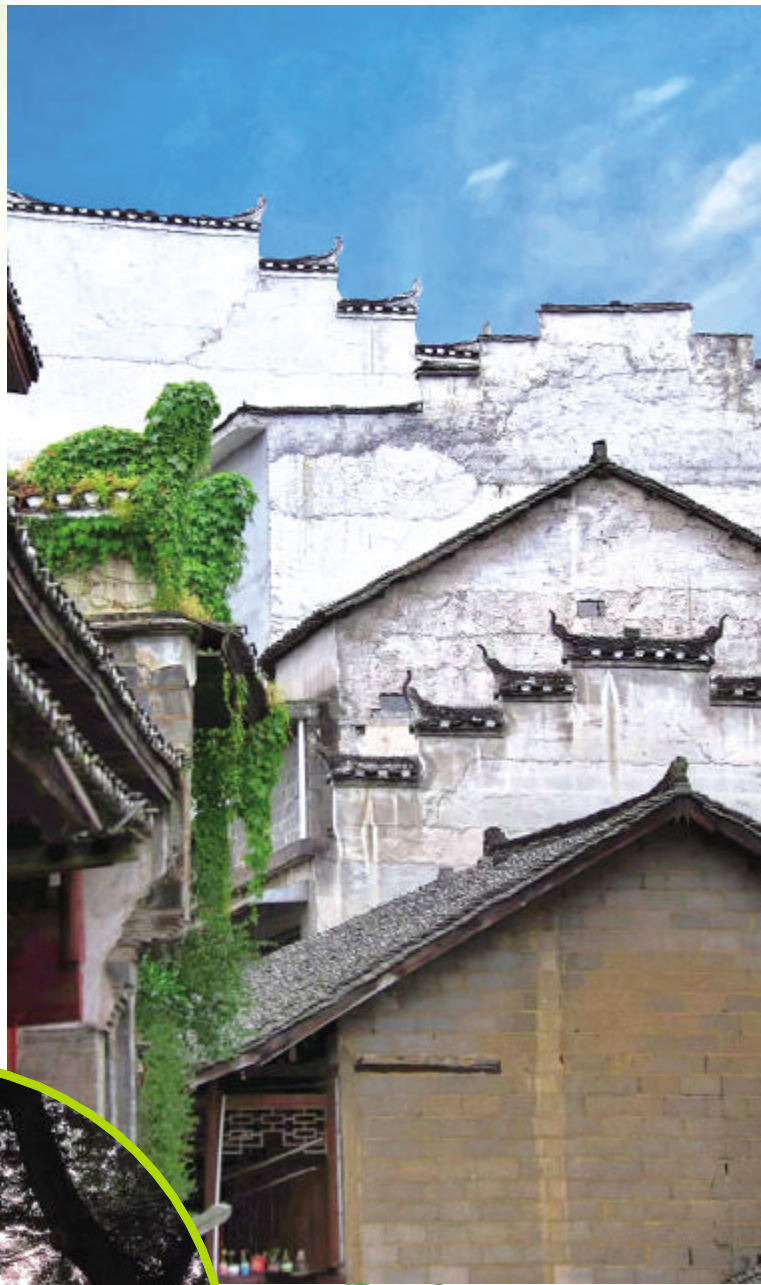
◎白墙老屋 冯小川 摄
