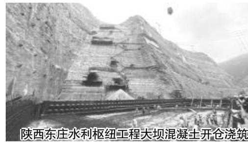
陕西东庄水利枢纽工程大坝混凝土开仓浇筑
